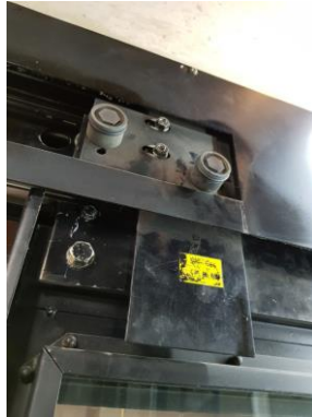
Serrure de porte palière du niveau principal
