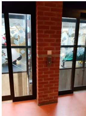
Commande palière du niveau principal
